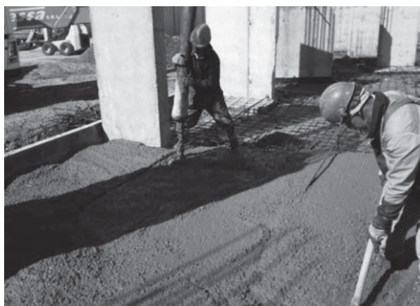
Подача бетона автобетононасосом
