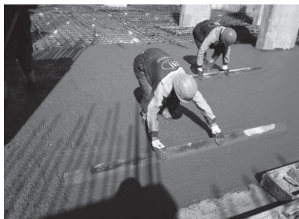
Укладка бетона без виброуплотнения
